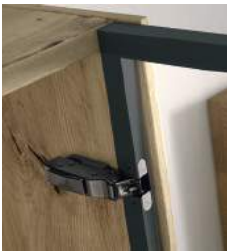
Detalle Bisagra para Puerta de Cristal
